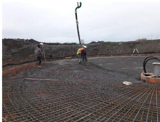
Coulage du radier du clarificateur (19/12/2019)
