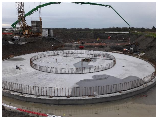
Radier du bassin d'aération (19/12//2019)
