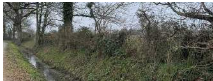
/ Fossé à Saint-Père-en-Retz Source: Cittànova, 24.01.2024
