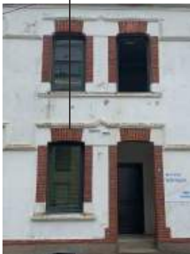
Encadrement de baies en briques
