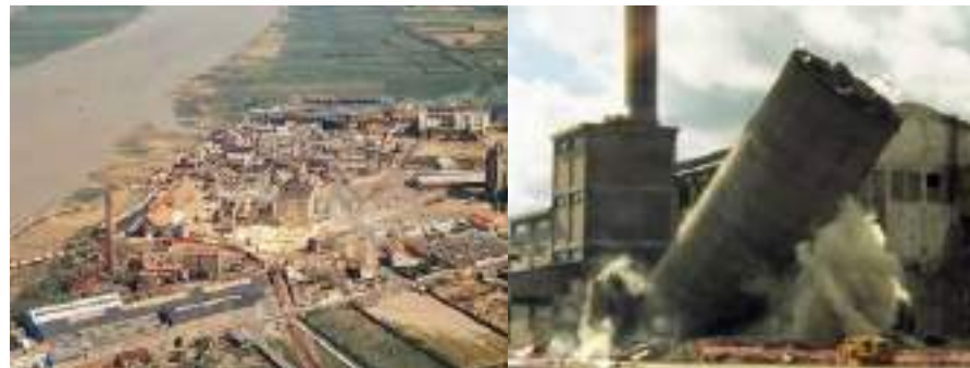
/Ancienne usine Kuhlmann sur les rives de Loire, Paimboeuf
