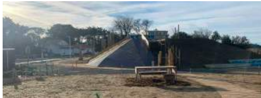
/Vestige de la casemate 105 à St-Brevin, reconvertie en aire de jeux Source : Cittanova, octobre 2023
