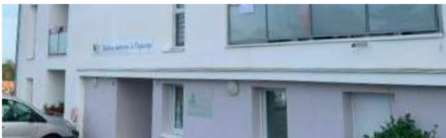
/Résidence Autonomie Le Béguinage, Frossay Source : Cittanova 29.11.2023
