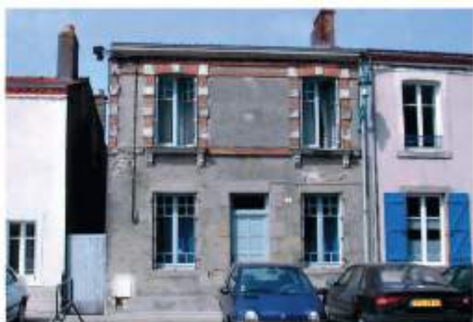
Maison de ville avant travaux.
