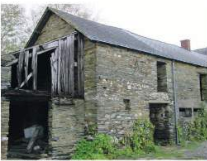
Le corps de ferme avant travaux
