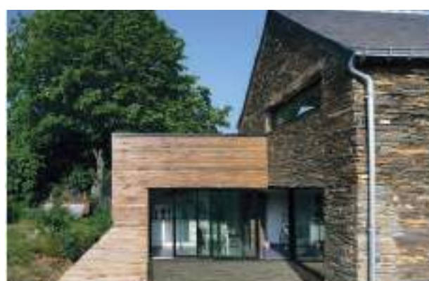
6 - Extension à Nozay. Le volume créé est en rupture avec le volume existant. Les grandes ouvertures créent le lien entre les deux parties de la maison.
