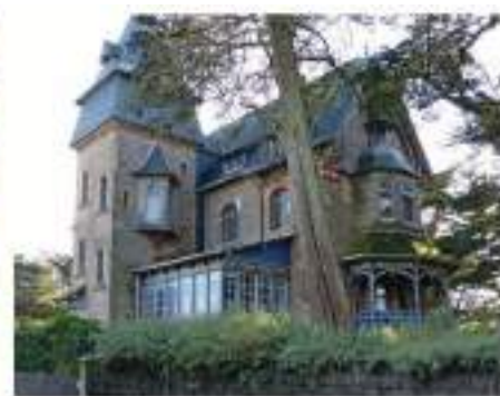
Véranda ancienne en bois d'une villa balnéaire.
