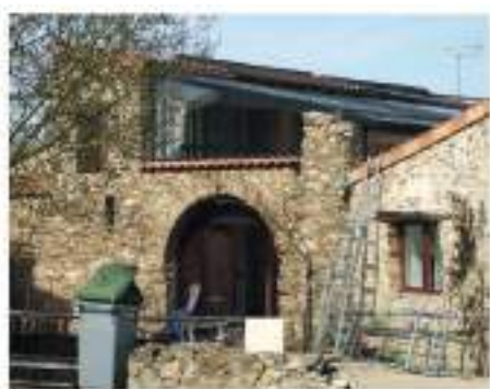
Intégration d'une véranda en aluminium.
