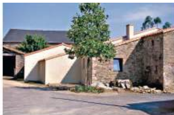
2 - Les extensions enduites reprennent les volumétries et les pentes de toit de la partie ancienne en pierre.
