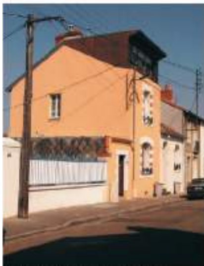
Surélévation en rupture sur une maison ancienne.
