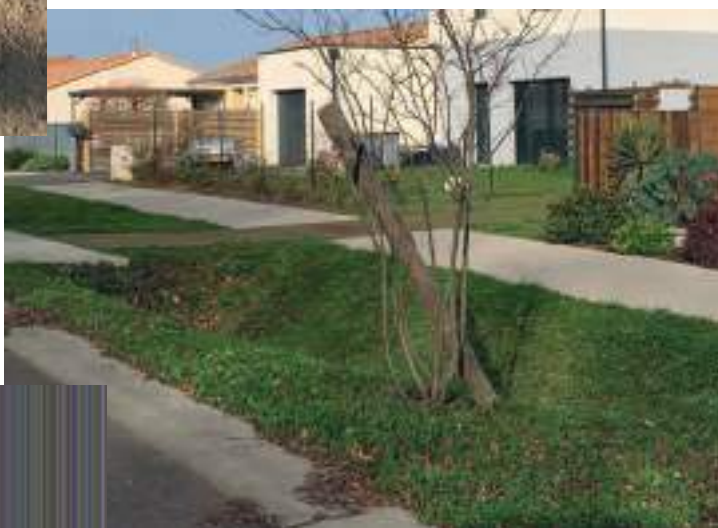
Noue végétalisée avec infiltration gravitaire à Saint-Père-en-Retz Source : Cittanova
