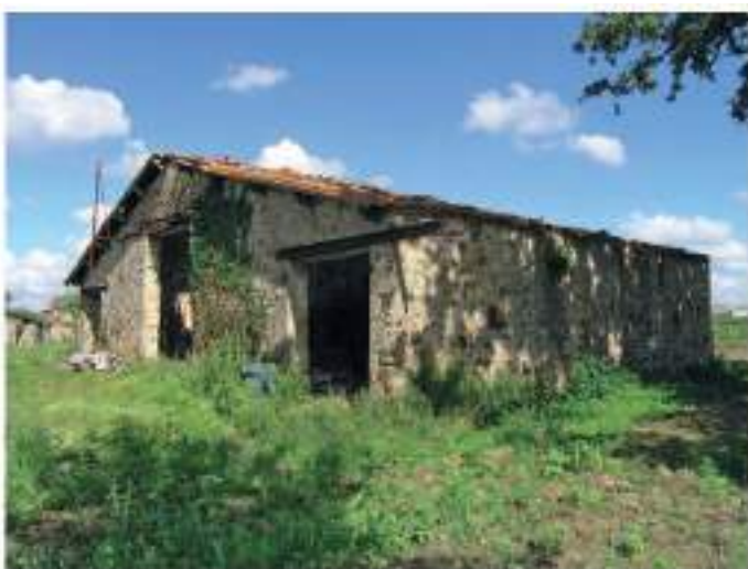
La grange avant travaux.
