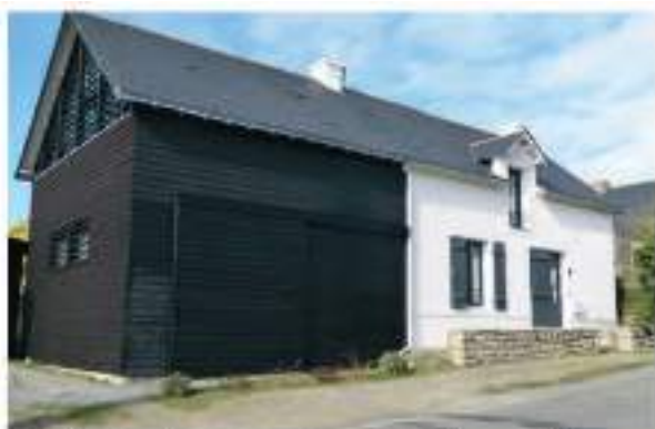
3 - L'extension se conforme au volume de la maison tout en marquant son côté contemporain avec le bardage noir et le pignon ajouré.
