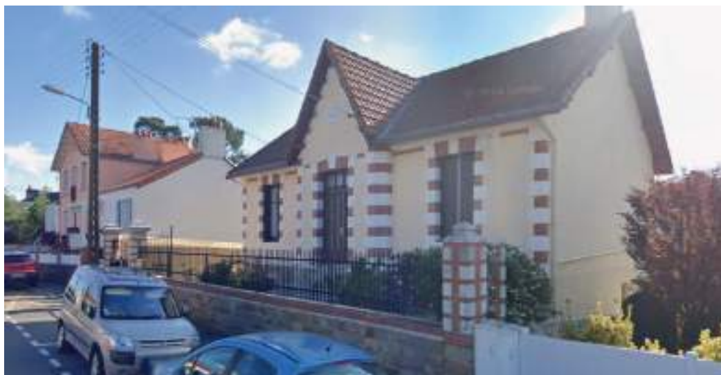
Maisons de faubourg du centre-ville Les Pins, Avenue du Maréchal Foch à Saint-Brevin-les-Pins
