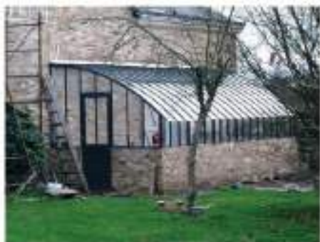
Véranda posée sur un soubassement en pierre.
