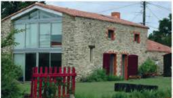
Transformation d'une ferme à Vallet. On remarquera que seul le pignon a été grandement ouvert préservant les percements de l'autre façade.
