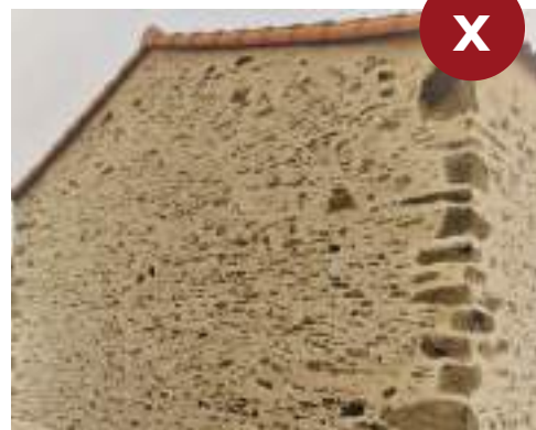
Enduit à pierres-vues
