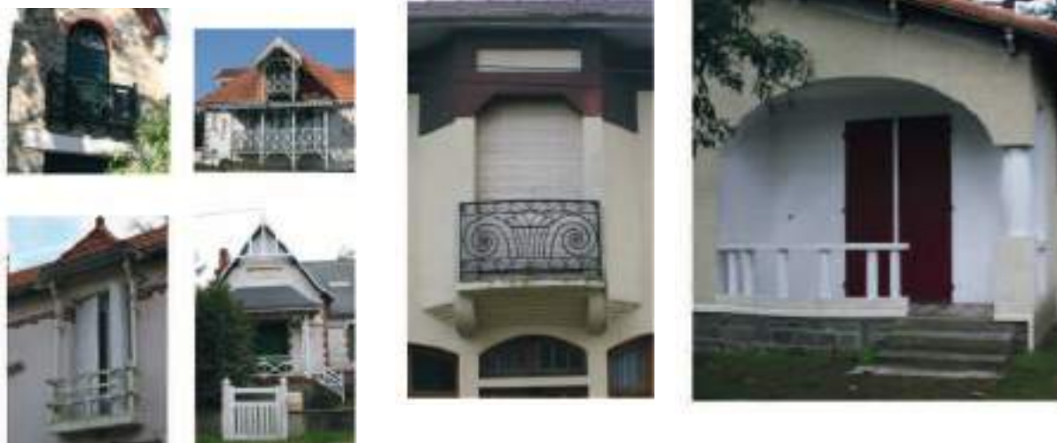
Balcons en bois, béton et métal patrimoniaux à Saint-Brevin-les-Pins
