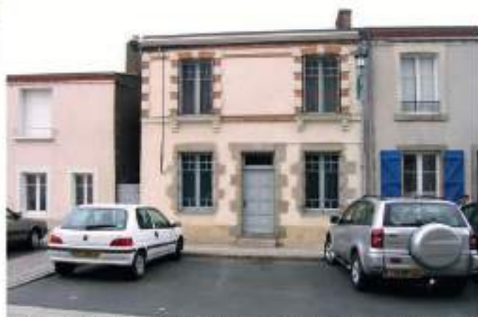
Maison de ville après travaux avec ses modénatures et son enduit ton sable.
