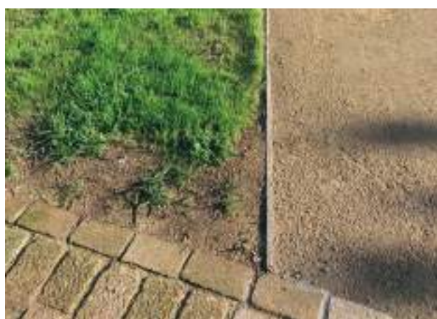
Noue végétalisée avec infiltration gravitaire à Saint-Père-en-Retz Source : Cittanova
