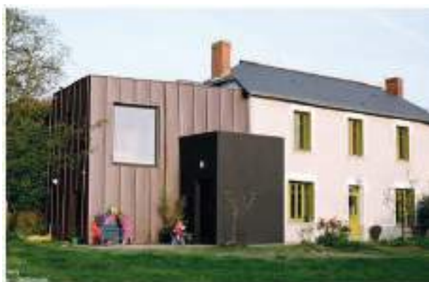
5 - Extension à La Grignonais. La volumétrie, mais également le matériau contraste avec la partie ancienne.
