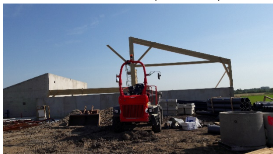
Aire de stockage (25/06/2020)
